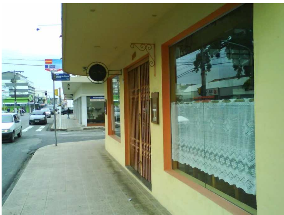
Figura 6: Fachada do imóvel Fonte: dados primários.
