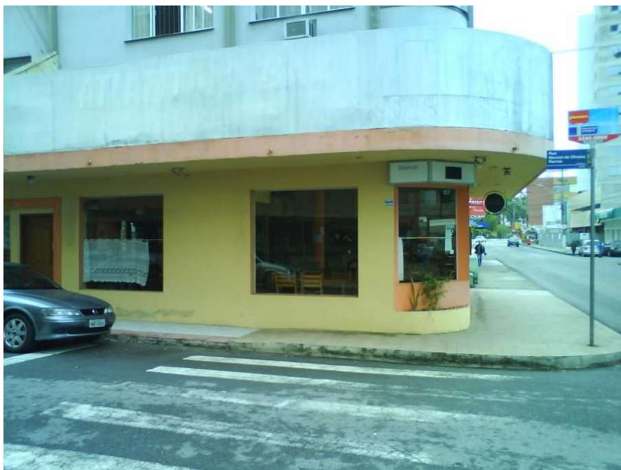
Figura 5: Vista lateral do imóvel Fonte: dados primários.
