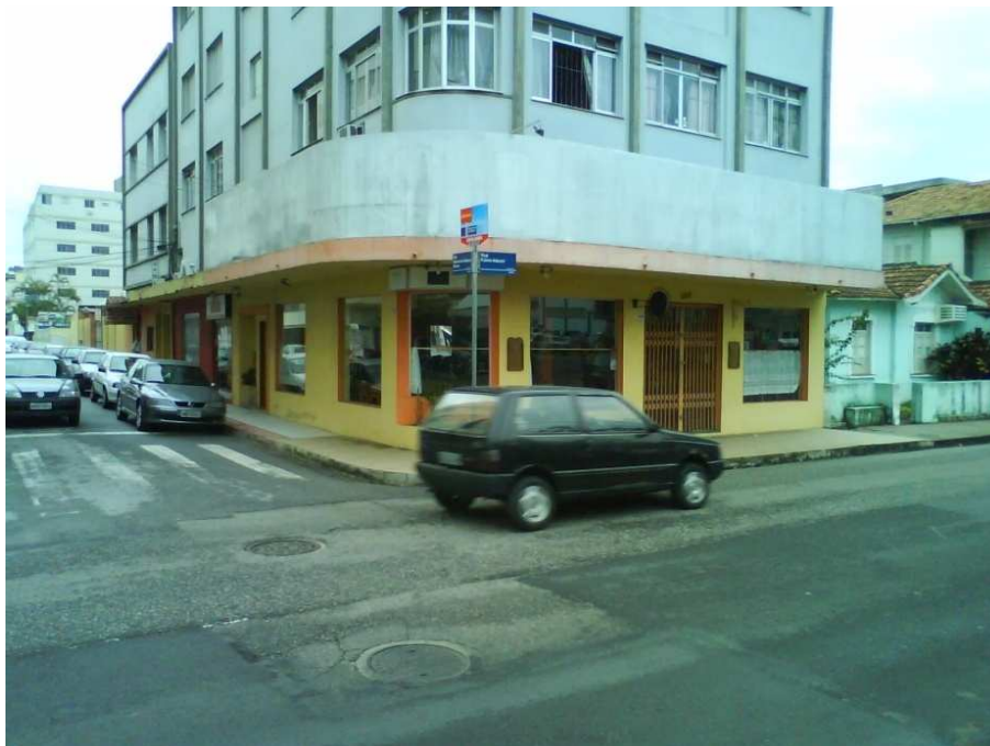
Figura 7: Vista frontal do imóvel Fonte: dados primários.
