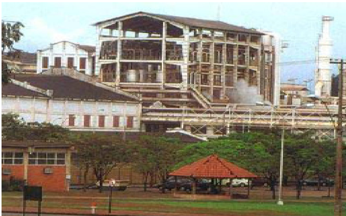
Figura 06 – Usina Termoelétrica - Biomassa
