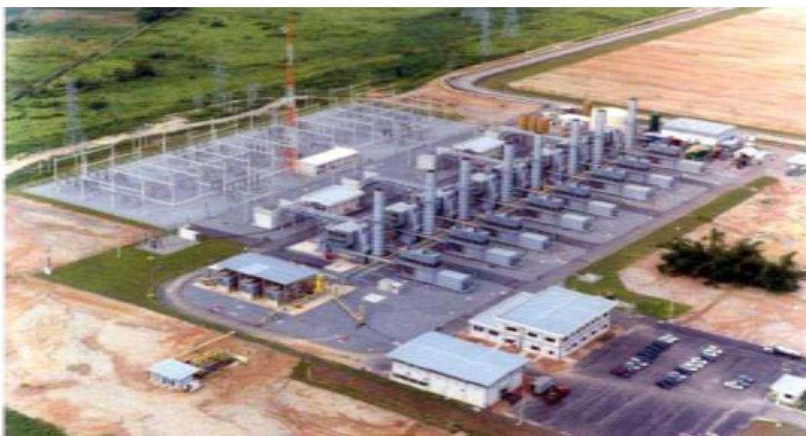
Figura 05 – Usina Termoelétrica a Gás
