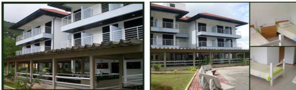
Figura 10 - Vistas externa e Interna do Centro de Hospedagem da ACIC Fonte: Arquivo da Acadêmica
