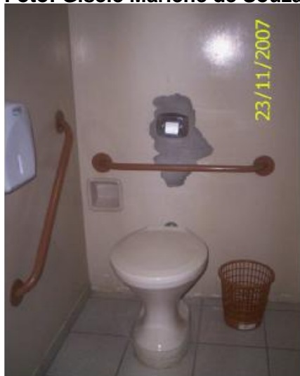
Figura 2 Banheiro adaptado para pessoas com deficiência, do Campus Florianópolis .
